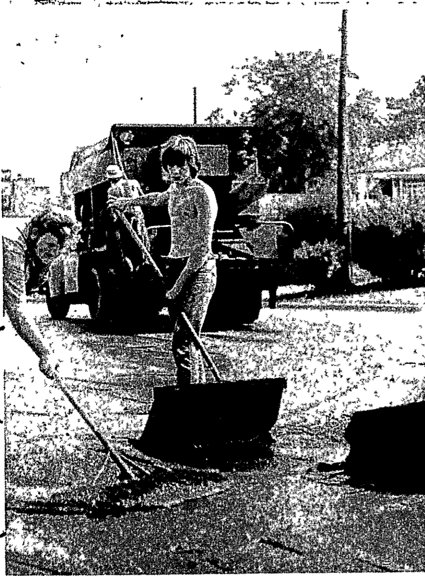
Pouring a new street
